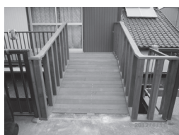
↑①2階のベランダから向かいの道路まで橋渡しを設置。
