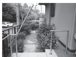
↑③玄関前に設置した遮断機式の手すり。
