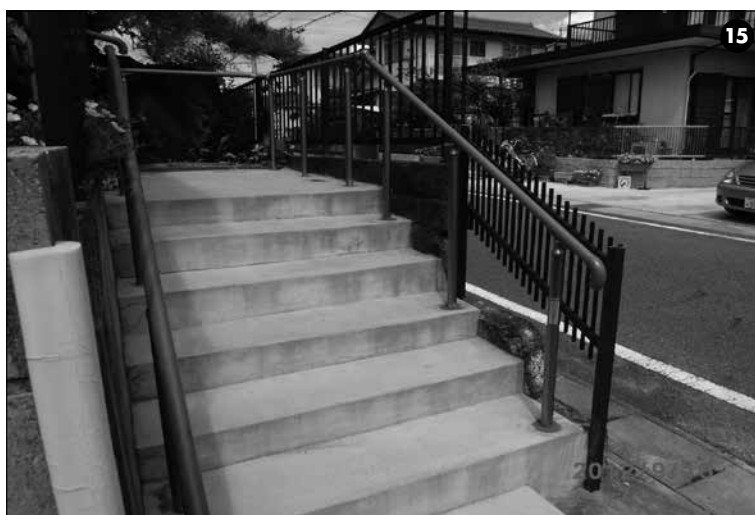
⑮新たに依頼主の身長に合わせ、高さ70cmの手すりを左右に設置。もとは向かって左側のみ(しかも高さは60cm)で、依頼主には低く危険だった。
