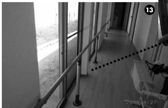
⑬老人ホームの長い廊下に手すりを設置。表へ出入りするサッシ部分は跳ね上げ手すりにして、出入り際には開けて⑭使う。認知症の方が外へ出るのも予防できる。
