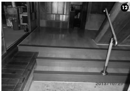
⑫奥の台所と向かって左側の居間がバリアフリーになるよう床面を新設。階段と手すりでも楽に上がれるようにした。
