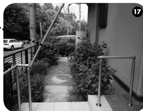
⑯前頁の写真⑬・⑭と同様、人が出入りする部分は跳ね上げ手すり(⑰)にして対応。
