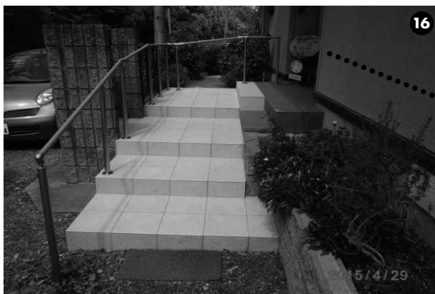
⑮新たに依頼主の身長に合わせ、高さ70cmの手すりを左右に設置。もとは向かって左側のみ(しかも高さは60cm)で、依頼主には低く危険だった。
