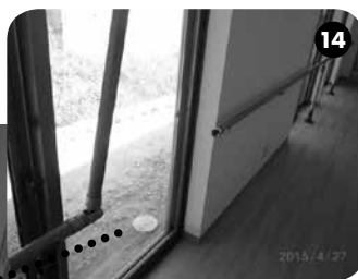
⑬老人ホームの長い廊下に手すりを設置。表へ出入りするサッシ部分は跳ね上げ手すりにして、出入り際には開けて⑭使う。認知症の方が外へ出るのも予防できる。
