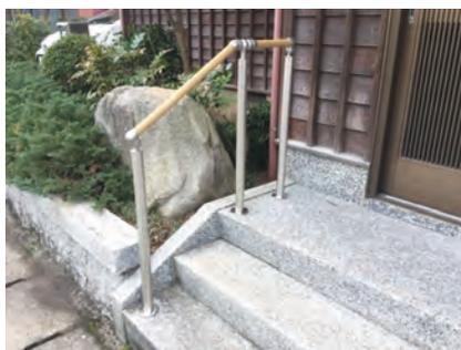
写真-13 | ポーチの階段部分に手すりを設置
