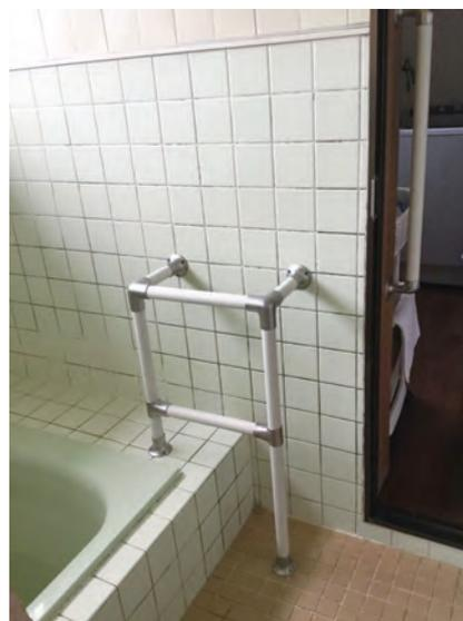
写真-12 | 浴槽出入りのための手すり。現場に合わせて加工
