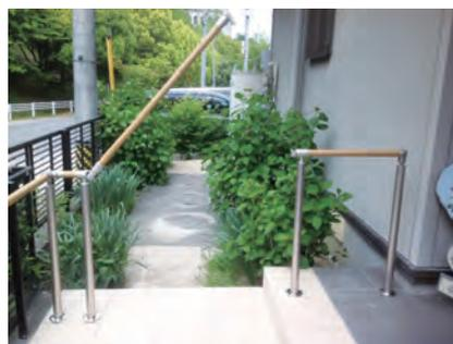
写真-14 | ポーチの階段部分に手すりを設置 (手すりを上げて通り抜け可能)
