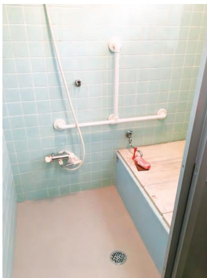
写真-11 | 横手すりと縦手すりを組み合わせてT字の逆さまのようになっている
